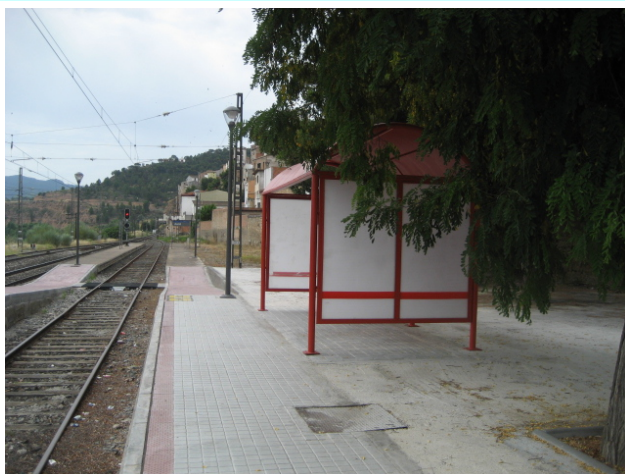
Foto. Marquesina de la RENFE a l'estació d'Ascó
