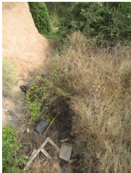
Foto. Canal d'abocament de les aigües residuals
