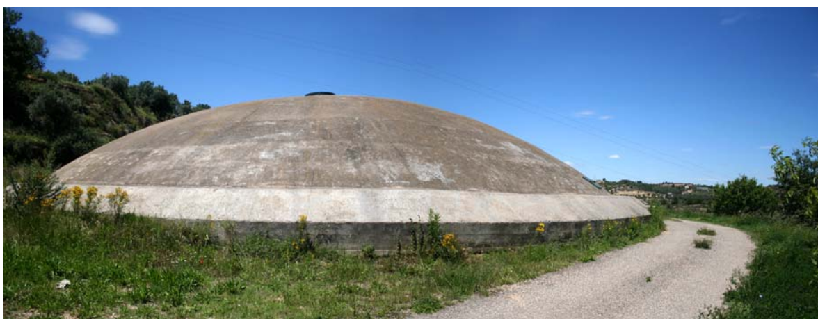
Foto. Dipòsit intermig d'aigua d'Ascó
