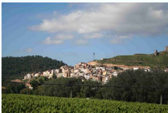
Foto. Detall d'un repetidor de telefonia a la part alta del casc urbà
