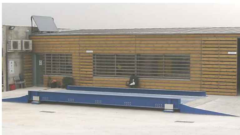
Foto. Sistema de pesatge de la deixalleria del Morell
